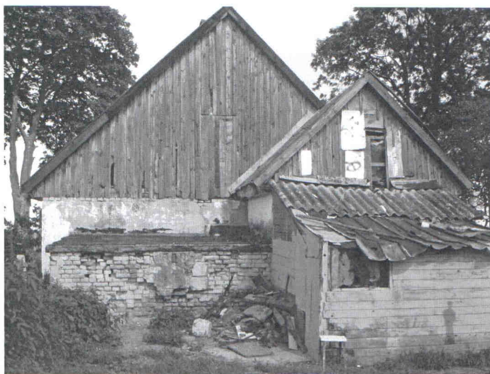
Widok od strony zachodniej
